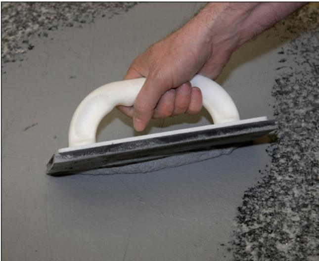
**5** Jointoiment des pierres naturelles avec un Joint Sopro (p.ex. Joint Sopro Déco Flex DF 10® ou Joint Sopro Brillant®).
