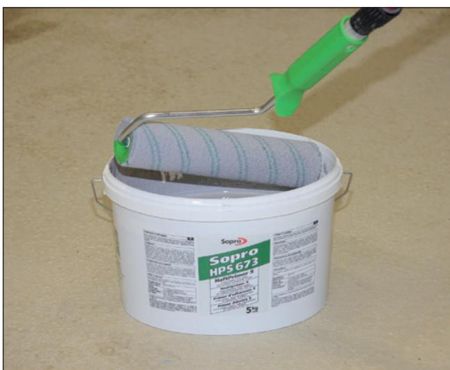
**6** Alternative à l'épandage de sable: après séchage de la première couche de Primaire universel Sopro MGR 637, il est possible d'appliquer une couche de Primaire Sopro HPS 673. Après séchage (de 1–2 heures), les travaux suivants peuvent commencer.
