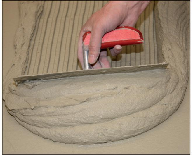
**2** Réalisation de la couche peignée de Colle coulante Sopro VarioFlex® XL sur la couche de contact préparée.
