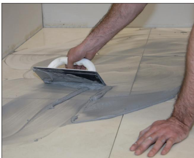
**5** Quand la surface est circulaire, procéder au jointoiment avec un Joint Sopro (p.ex. Joint D'co Flex DF 10®).
