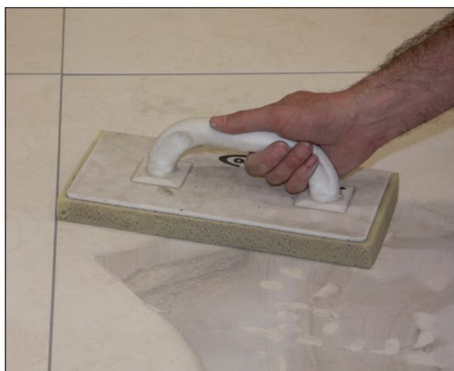
**6** Nettoyage des carreaux après prise suffisante du Joint Sopro appliqué.
