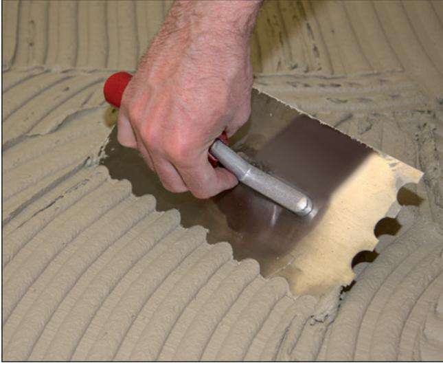
**1** Application de la Colle VarioFlex® XL, en consistance de mortier de pose, sur la couche de contact préparée.
