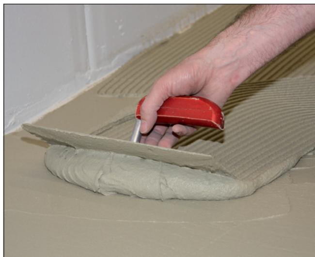
**2** Application de la Colle VarioFlex® XL, en consistance de mortier colle, sur la couche de contact préparée.
