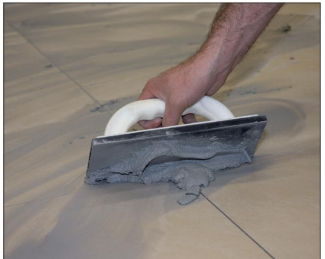
**6** Jointoiment avec un Joint Sopro (p. ex. Joint Sopro Déco Flex DF 10®, Sopro Brillant® ou Joint flexible Sopro FL), puis nettoyer la surface.
