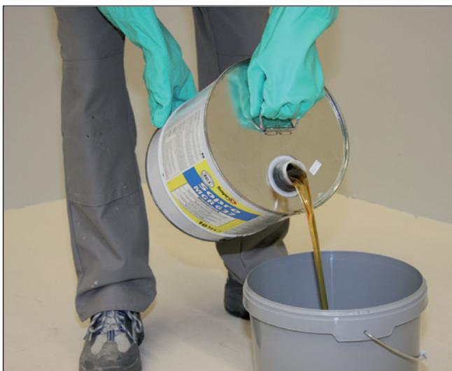
**2** Tout spécialement pour la pose d'éléments de grand format,  $\geq 40 \times 40$  cm, traiter la surface avec le Primaire universel Sopro MGR 637 afin d'empêcher toute remontée d'humidité. Pour une mise en œuvre simplifiée, le produit monocomposant sera transvasé dans un seau propre et sec.
